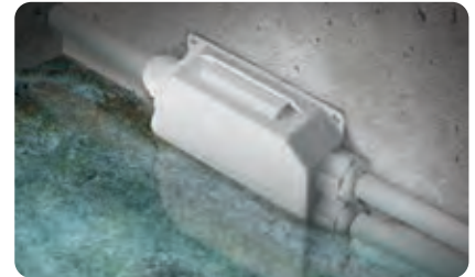
Installation avec tuyaux.
